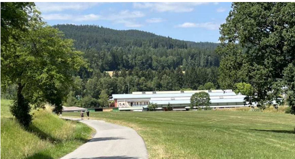
Abbildung 109: teilweise fehlende Eingrünung des Gewerbegebietes „Am Moosbach“ entlang der Ostseite; Blickrichtung nach Westen, 2023 (Quelle: brunner architekten)
